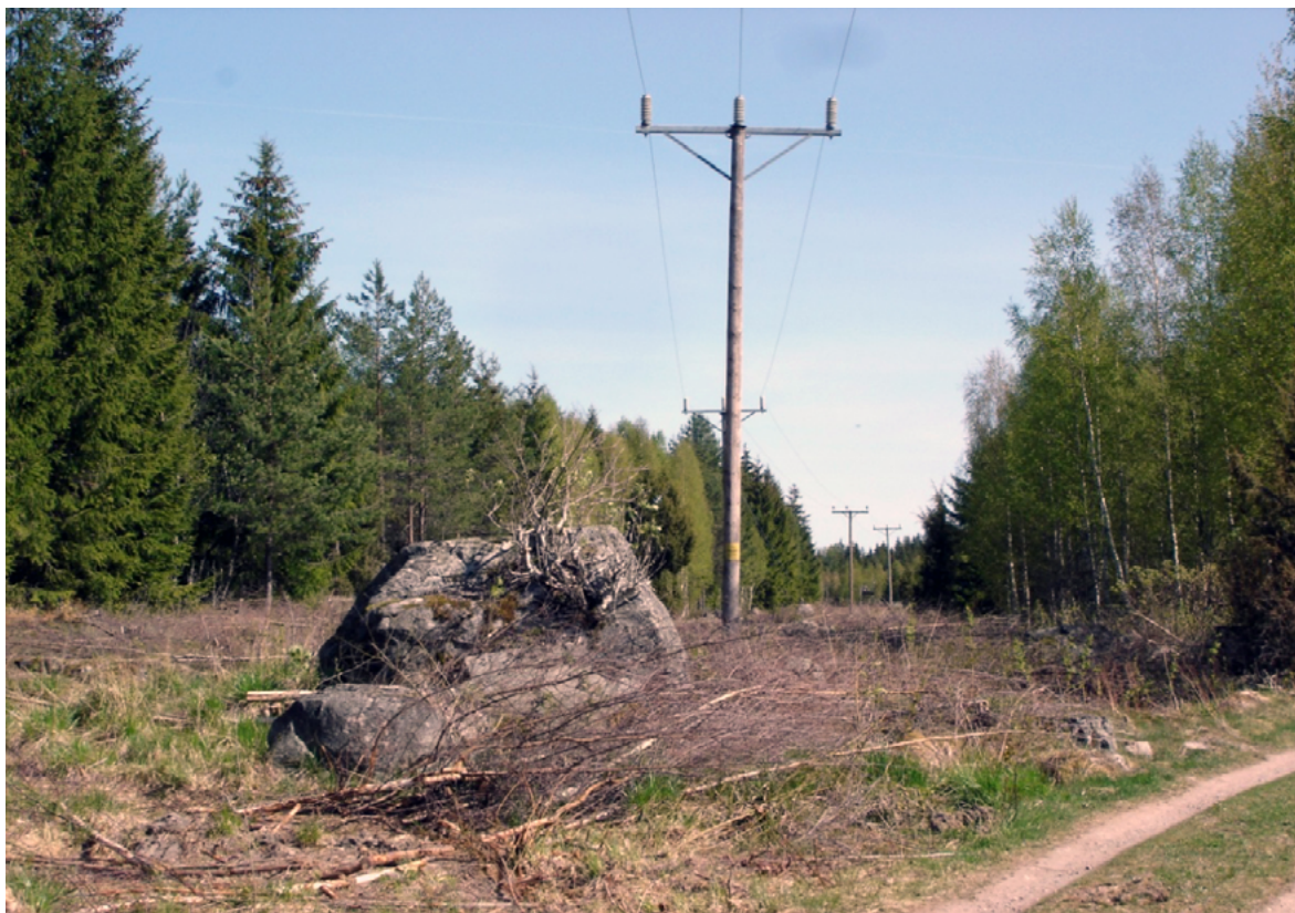
Luftledning med oisolerade ledare, 40 kV.
