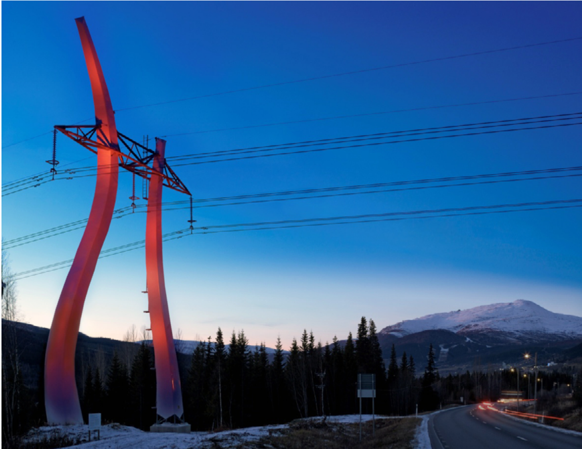
Svenska kraftnätets första designade kraftledningsstolpe utanför Åre. Stolpen invigdes 2009 och är en del av 400 kV-stamnätetsledning mellan Järpströmmen och Nea i Norge.
