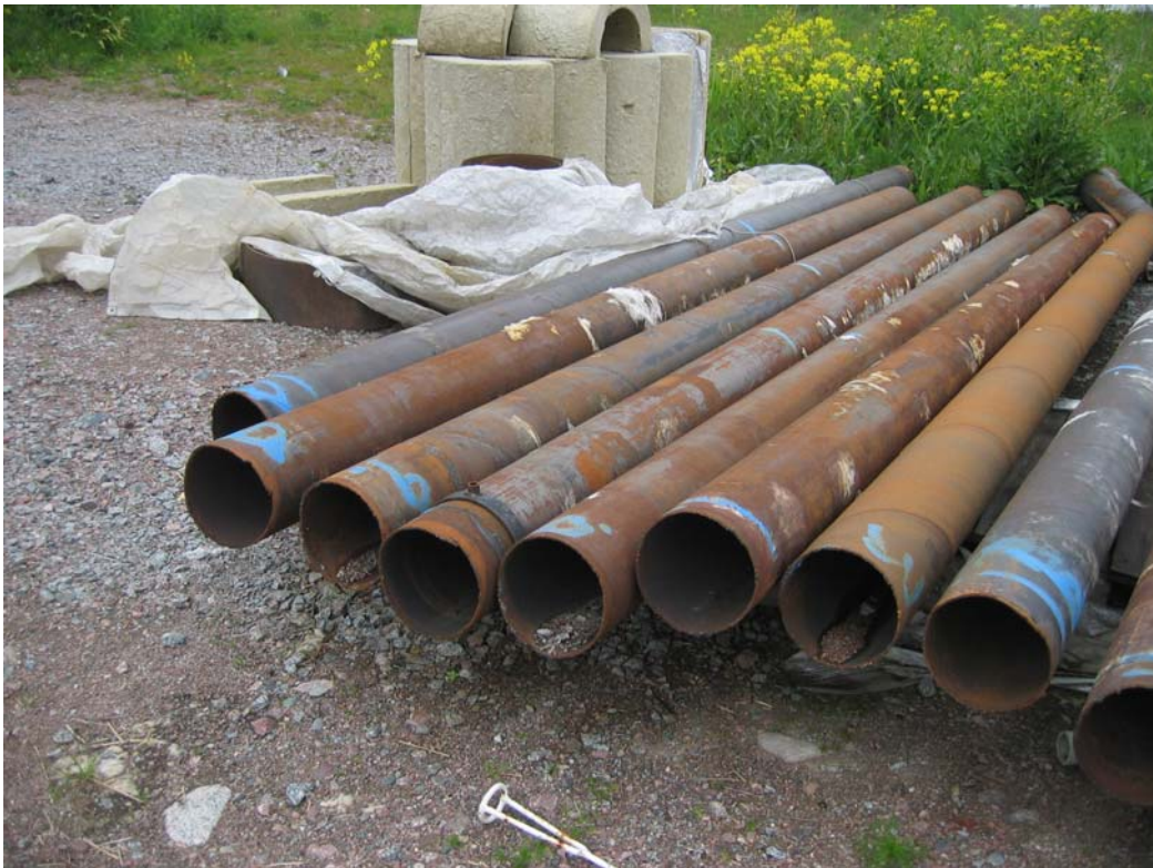
Bild 10 Frilagda fjärrvärmerör från Sköldungagatan, Uppsala. Dessa är huvudsakligen angripna av ytrost, med lokalt större angrepp. På en del ställen fanns skyddsmålningen kvar.
