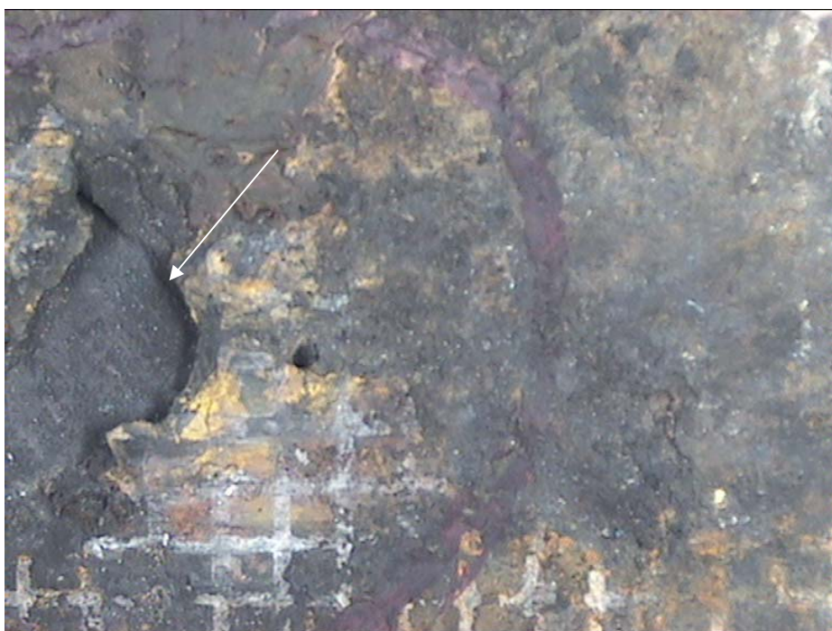
Bild 21 Provbit nr 1. Själva läckagearean var liten som ett knappnålshuvud och fanns under "kanten" vid pilen.
