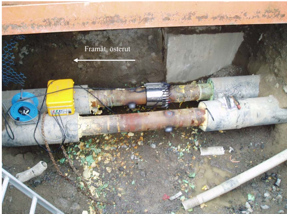
Bild 7 Monterat Teletestverktyg på fjärrvärmerör i Lunda industriområde, Stockholm.
