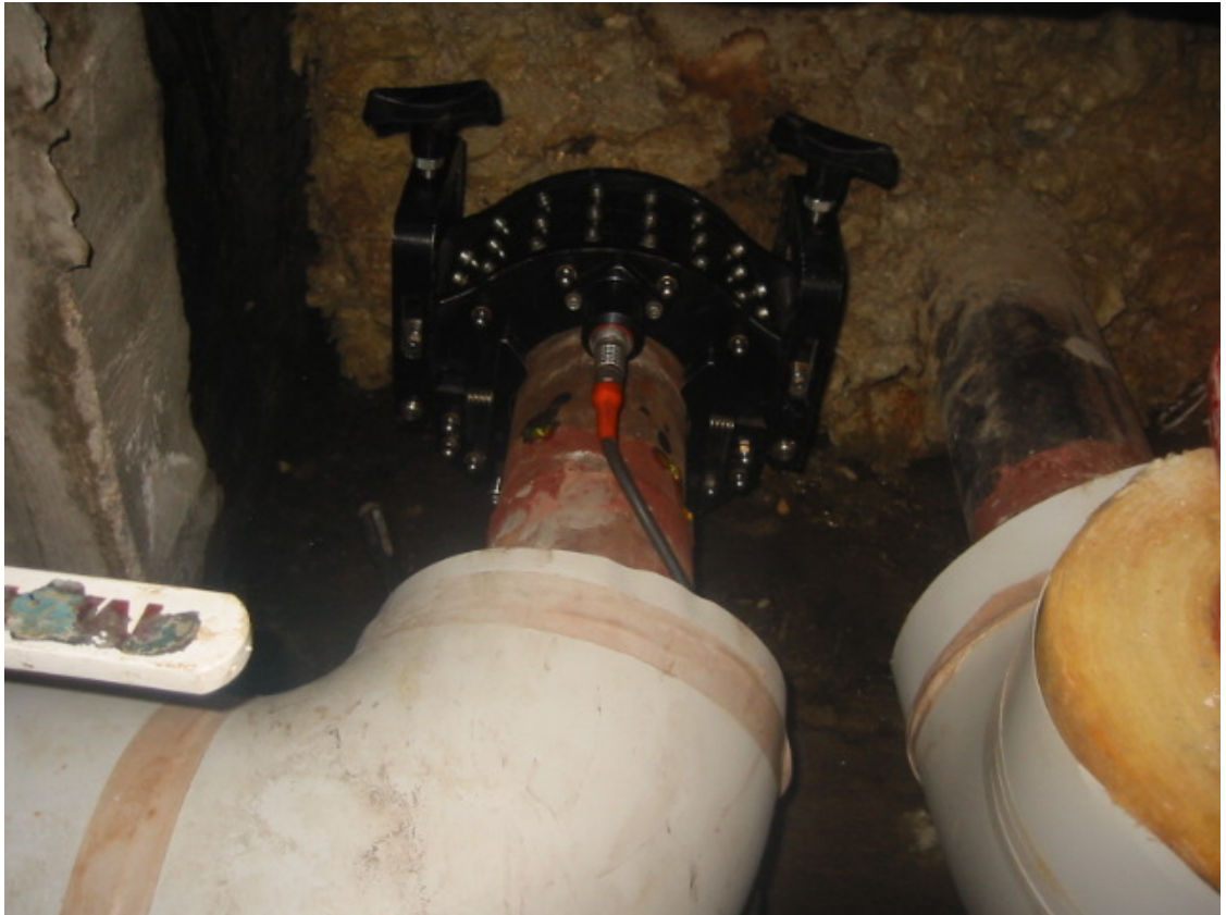
Bild 9 Teletestinstrumentet placerades inne i kulverten, efter att isoleringen hade avlägsnats.
