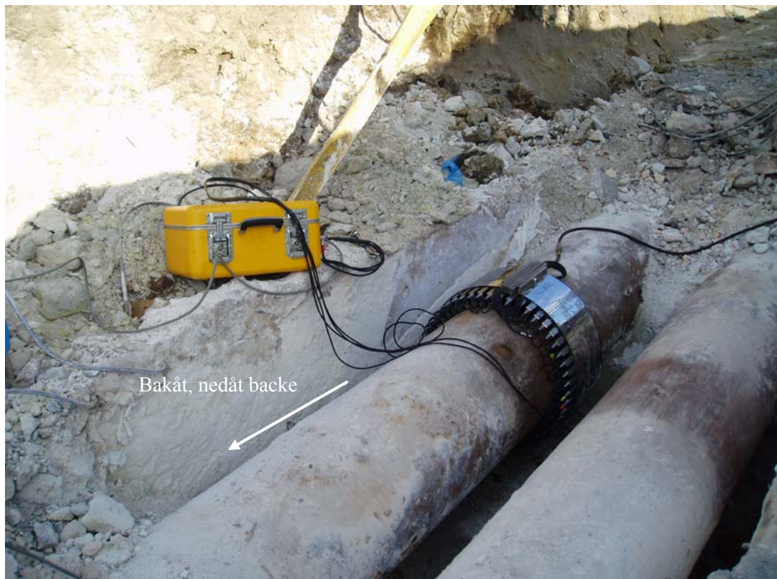
Bild 6 Monterat Teletestverktyg på fjärrvärmerör i Rinkeby, Stockholm
