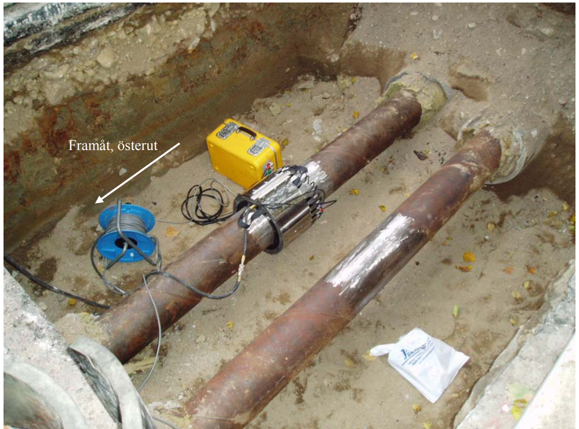
Bild 4 Monterat Teletestverktyg på fjärrvärmerör på Sköldungagatan, Uppsala
