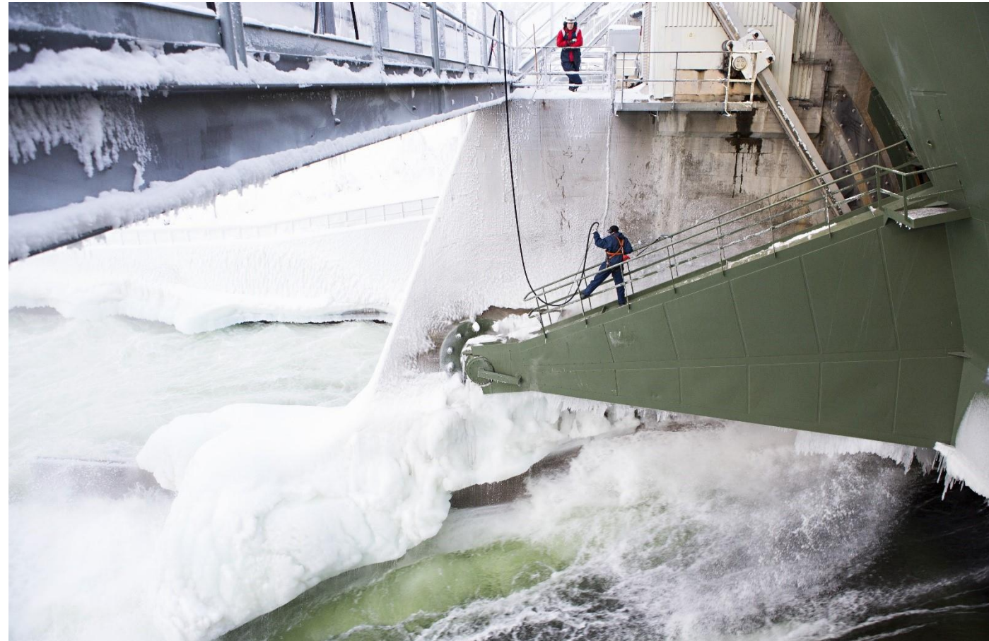
Avisning av utskovslucka. Foto: Vattenfall
